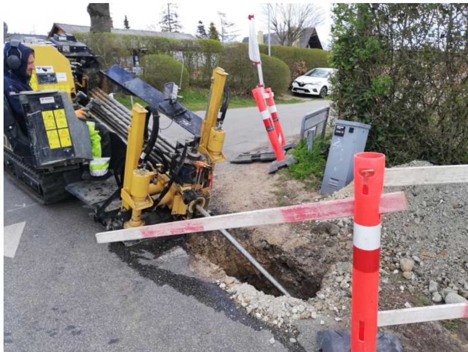
Det er noget af en maskine, der skal til for at bore fiberrørene i jorden. Foto: F. Damgaard
