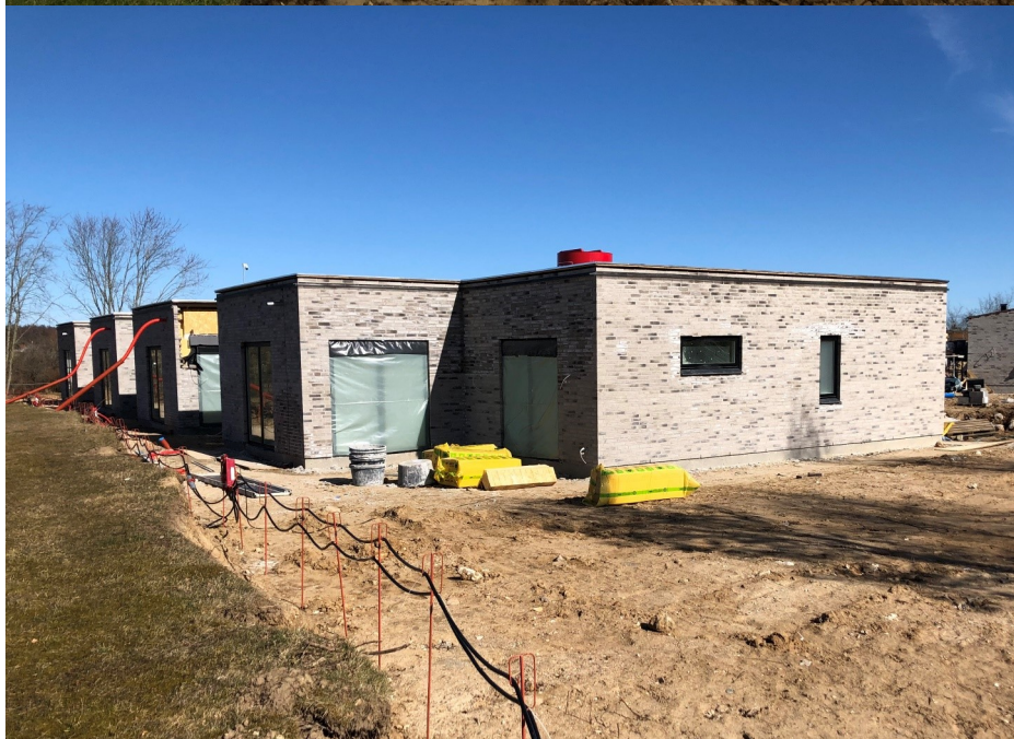
Øverst: Fundament, december 2020. Nederst: Samme sted, marts 2021. Foto: CH
