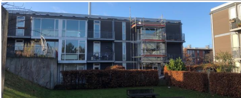
Udskiftningen af vinduer og døre er i fuld gang i Egestrædet. Foto: C. Holtermann
