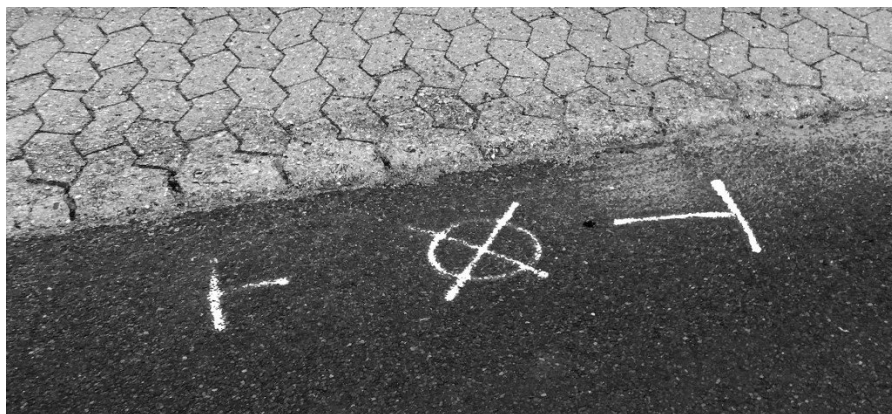
Markering af ny lysmast
