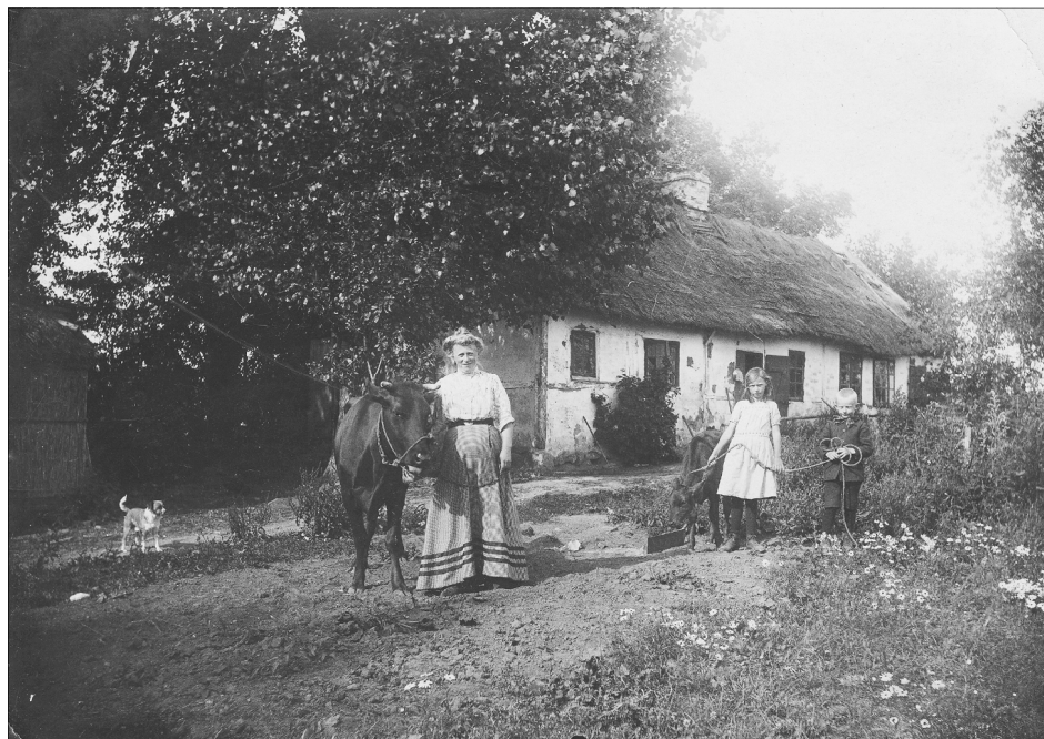
Vilhelms Neumanns barndomshjem indtil 1914 (Egebjergvej 94), hvor det blev nedrevet. På billedet ses Gerthine (fortællerens mor), hans søster Johanne og Vilhelm Neumann selv.
