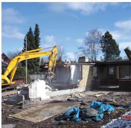
Egebjergvej nr. 82 under nedrivning
