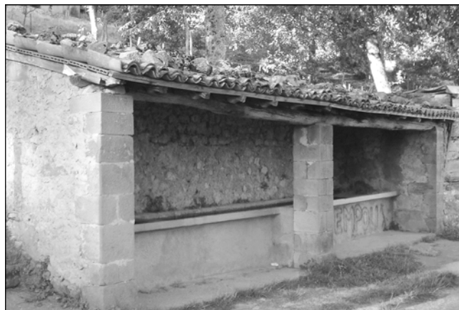
Det gamle vaskeri. Der løb stadig frisk vand ned i bassinerne.
